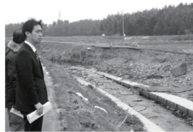
2013年2月1日浪瀬川現場視察
