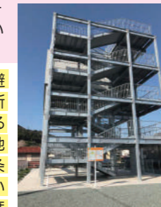
南伊勢町の津波避難タワー
