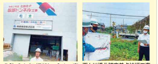
北勢バイパス坂部トンネル工事 百々川橋北詰交差点拡幅工事
