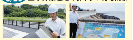
伊船町通学路工事 下箕田地区海岸堤防工事
