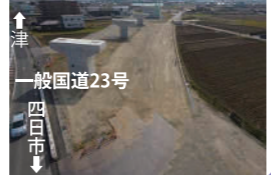
中勢バイパス4工区 状況 (令和5年度全線開通予定)
