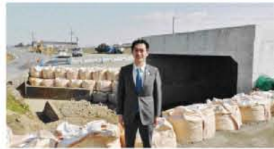
▲現在工事中の県道平野亀山線にて
